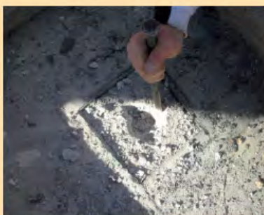
3ª fase: asportazione della cappa di Cls, gettata sopra l'alleggerimento in argilla espansa sciolta. La cappa, risulta perfettamente asciutta nel suo spessore.
