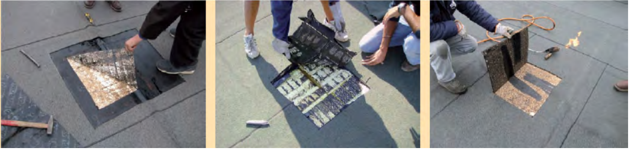
Delaminazione della membrana in bitume polimero dal polistirene per effetto del calore.
