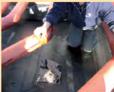
1ª fase: asportazione dello strato impermeabile, al suo intradosso lo strato termoisolante appare perfettamente aderente ed asciutto a dimostrazione che non è penetrata acqua sotto l'elemento di tenuta.
