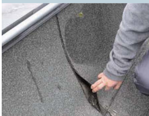
Risvolto verticale in membrana in bitume polimero, realizzato in continuo tra superficie corrente e supporto verticale di contenimento. Si nota l'andamento diagonale del risvolto in tensione, dovuto a ritiro della membrana e la conseguente apertura, delle giunzioni di saldatura al piede del risvolto.
