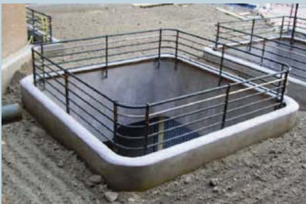
Completamento della protezione in rete + intonaco, di basamenti parapetti di prese d'aria, in una copertura a giardino pensile.
