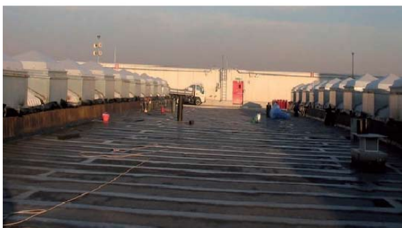
Coperture realizzate con membrane in bitume polimero tradizionali
