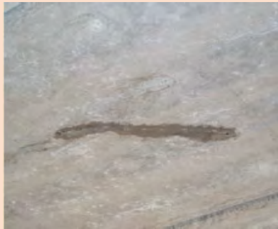
Solaio alleggerito con polistirene espanso – gocciolamenti in atto. Tracce di macchie e gocciolamenti, ormai esauriti.
