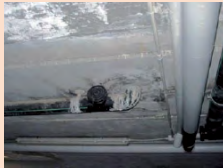
Solaio alleggerito con polistirene espanso – gocciolamenti in atto. Tracce di macchie e gocciolamenti, ormai esauriti.
