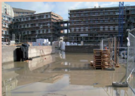
Solaio prefabbricato, alleggerito con cavità precostituite – situazione in opera, prima della posa degli strati impermeabili.
