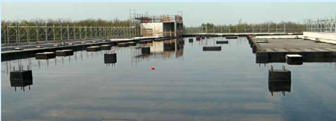
■ Collaudo con invaso d'acqua di una copertura.
