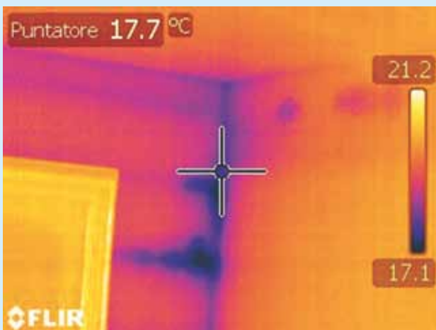
■ Collaudo di infiltrazioni a parete con termografia.
