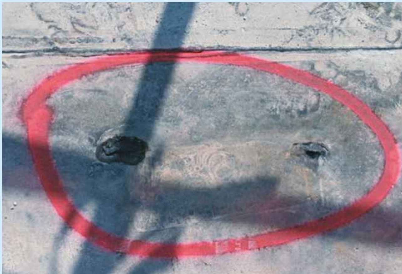
■ Controllo visivo dello strato impermeabile.
