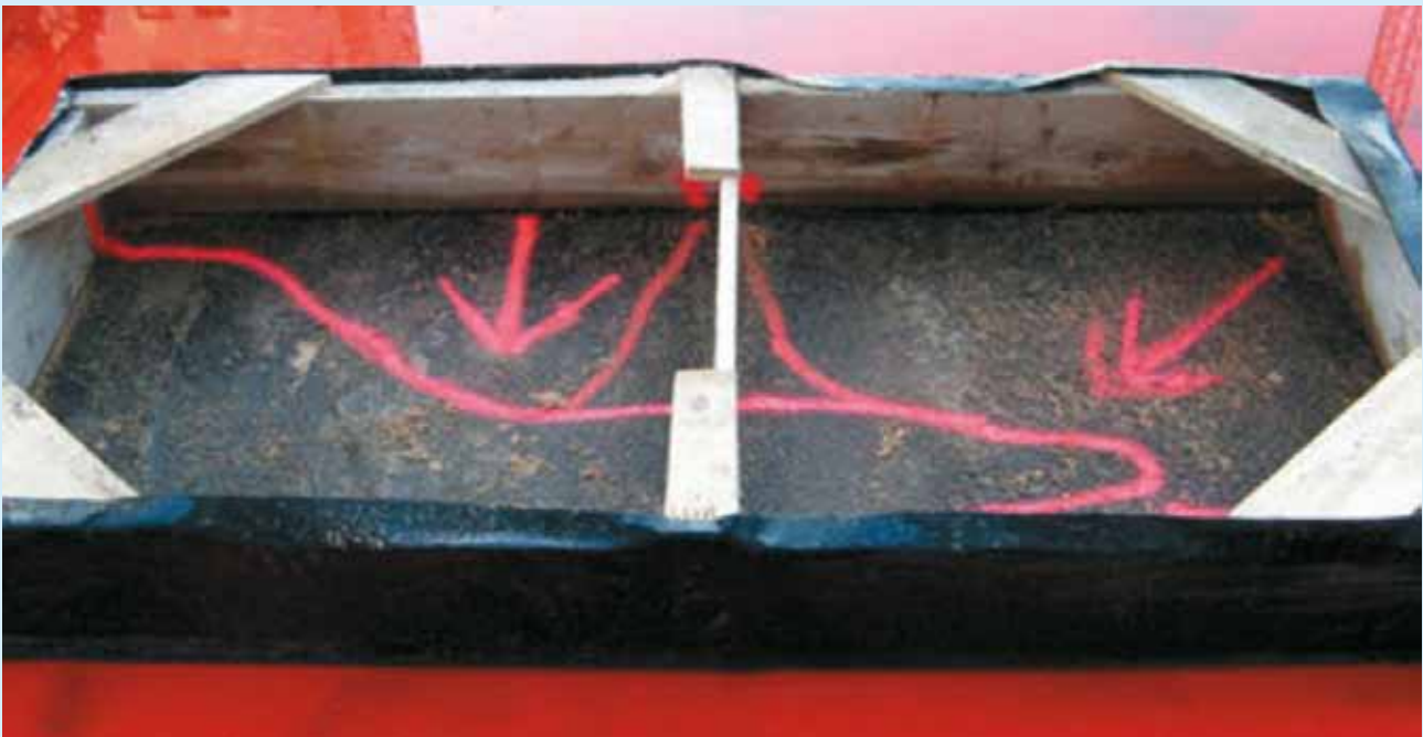
■ Collaudo con pozzetto d'ispezione aperto ed invaso esterno con acqua colorata.
