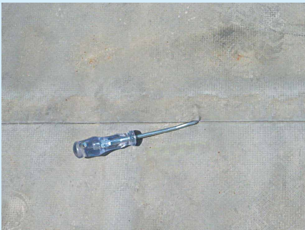
■ Controllo meccanico delle giunzioni dello strato impermeabile.
