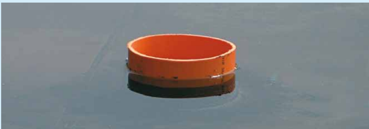
■ Chiusura scarico con tubo a sfioro (troppopieno di sicurezza).
