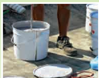
5 - Miscelazione del prodotto ELASTOSINT PU
