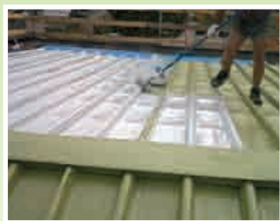
6 - Posa del 1° strato di ELASTOSINT PU
