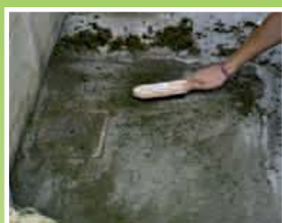
1 - Pulizia del supporto
