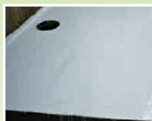
7 - Posa del 2° strato di ELASTOSINT PU
