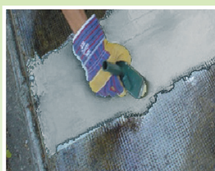
6 - Posa del 1° strato di ELASTOSINT PU
