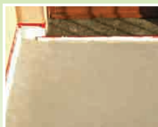
7 - Posa del 2° strato di ELASTOSINT PU con spolvero di quarzo
