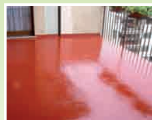
8 - Posa dell'ELASTOSINT PU TOP COLOR rosso
