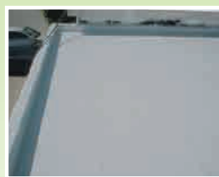
7 - Posa del 2° strato di ELASTOSINT PU
