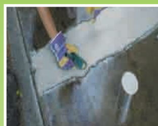
4 - Posa di una banda di rinforzo ARMOFLUX PE 50
