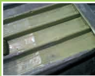
3 - Posa del PRIMER METAL
