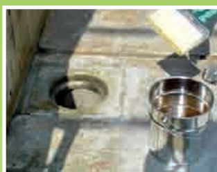
2 - Posa del PRIMER SB
