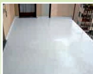
6 - Posa del 1° strato di ELASTOSINT PU
