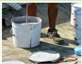
5 - Miscelazione del prodotto ELASTOSINT PU
