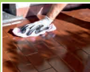
3 - Posa del PRIMER TILE
