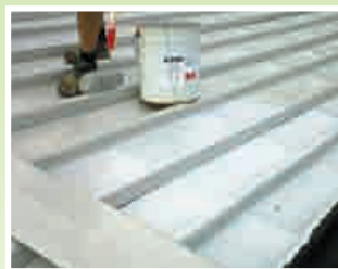
7 - Posa del 2° strato di ELASTOSINT PU
