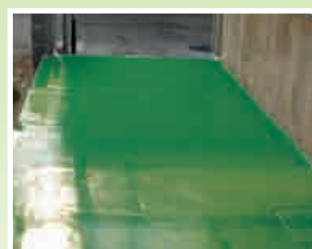
8 - Posa dell'ELASTOSINT PU TOP COLOR verde
