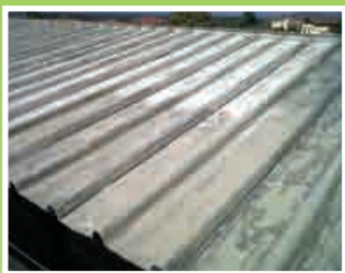
1 - Preparazione e pulizia
