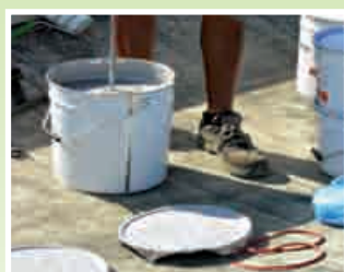
5 - Miscelazione del prodotto ELASTOSINT PU
