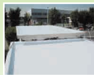
8 - Posa dell'ELASTOSINT PU TOP COLOR BIANCO REFLECTA
