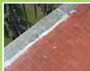
4 - Sigillatura crepe e fessure con RHENFLEX PU
