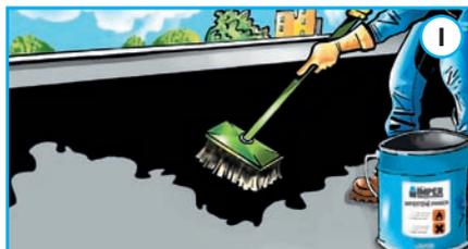
Ricordiamo di effettuare un'accurata preparazione e pulizia del supporto, eventualmente seguita (nel caso di superfici particolarmente polverose) dal trattamento di imprimitura con IMPERTENE PRIMER (applicato a spazzolone, rullo, spruzzo), con un consumo di 0,2÷0,3 l/m<sup>2</sup> e comunque variabile col grado di porosità del supporto stesso. **(dis. 1)**
