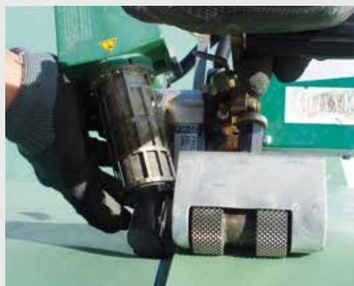
La complessità intrinseca dell'opera e la non ispezionabilità del rivestimento impermeabile in fase post opera hanno richiesto lo sviluppo di tecniche di produzione e sistemi di controllo e collaudo per verificare l'integrità dell'impermeabilizzazione in fase operativa prima del getto del rivestimento definitivo in calcestruzzo.
